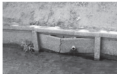
アーム柵パネルの破断
